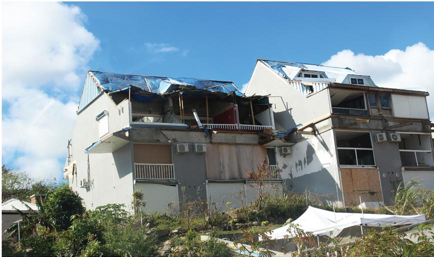
Figure 3 : Désordres sur parties légères d'ouvrages maçonnés
