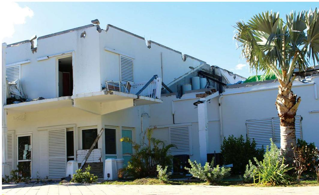
Figure 3 : Rupture due à l'arrachement de la charpente
