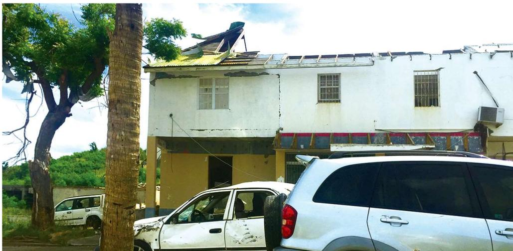
Figure 2 : Structure dégradée au niveau des chaînages
